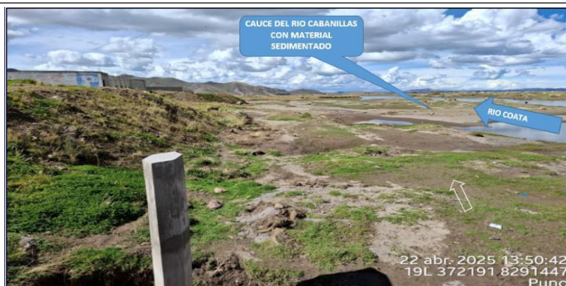
FIGURA 1 y 2 : TRAMO CRÍTICO EN EL RÍO CABANILLAS, EN EL SECTOR UNOCOLLA, DISTRITO DE JULIACA, PROVINCIA DE SAN ROMAN- PUNO. NOTESE, LA ACUMULACION DE MATERIAL SEDIMENTADO EN EL CAUCE, QUE REQUIERE SER ELIMINADO PARA REESTABLECER LA SECCION HIDRAULICA DE LA CAJA DEL CAUCE EN ESTE SECT OR.
